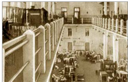
Механический цех завода коммуны: стеклянная крыша, много света
