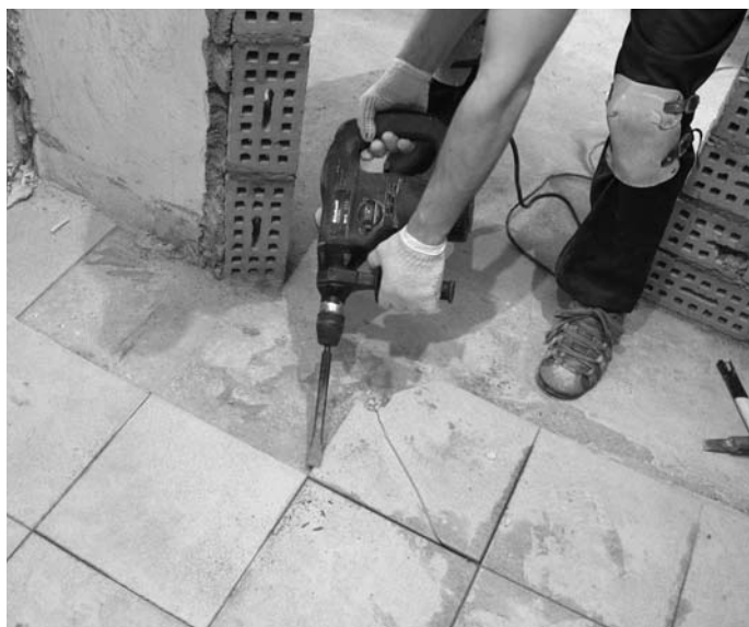
Рис. 1.4. Зубило вставляют под край плитки
