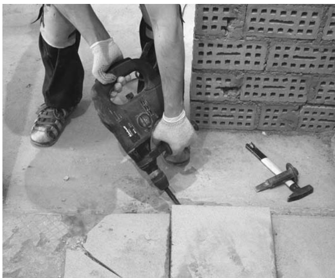
Рис. 1.5. Инструмент ведут вглубь
