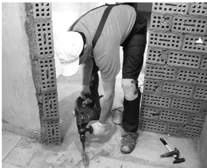
Рис. 1.3. Сбивание плитки перфоратором с инструментом «зубило» с широкой или узкой лопаточкой
