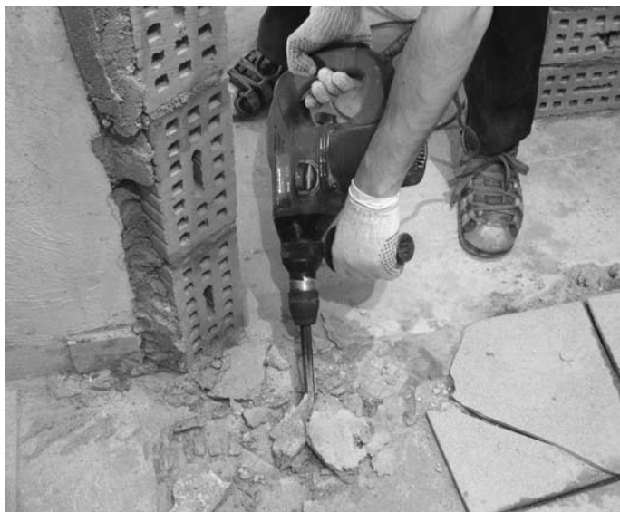
Рис. 1.6. Старый плиточный клей или цементный раствор сбивают тем же инструментом
